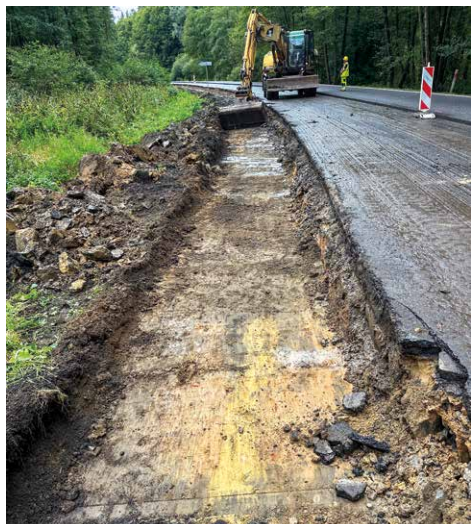
I/9 Želízy – hranice kraje, oprava komunikace a odvodnění
